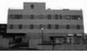
データセンター
